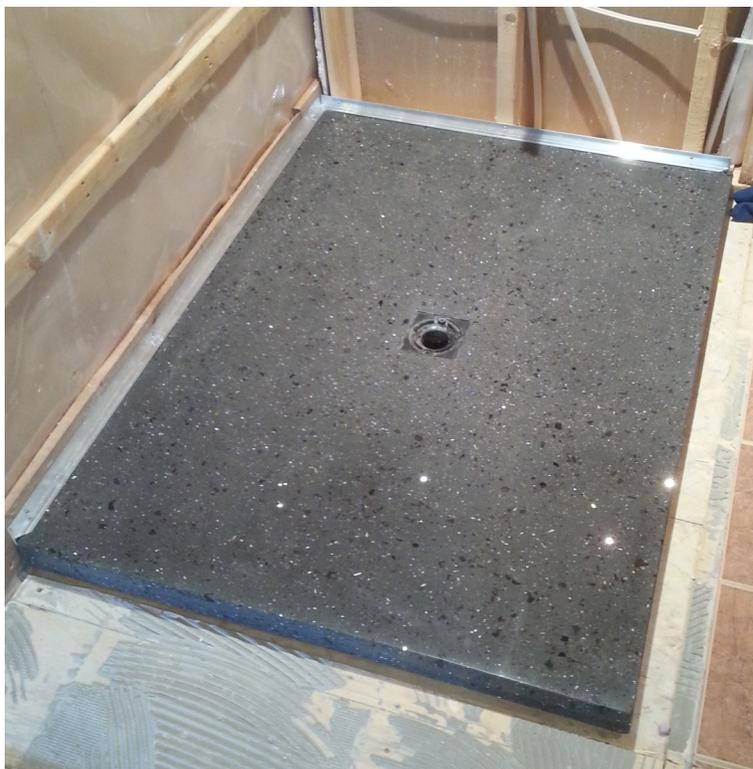
Doit être installée sur une surface plane (contreplaqué ou auto nivelant).
